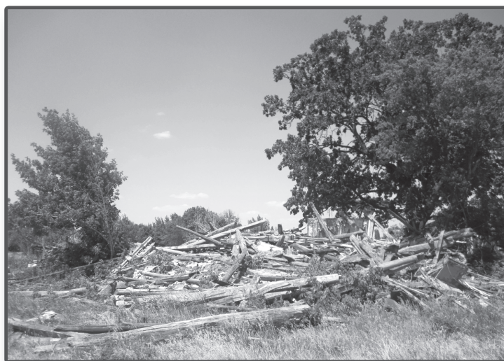
За разрушенным домом священника Федотова виден дуб и домик, где врачевал Чехов
